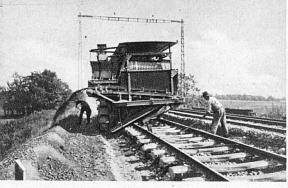
Machine à dégarnir et cribler le ballast des voies de chemins de fer Syst. Scheuchzer
