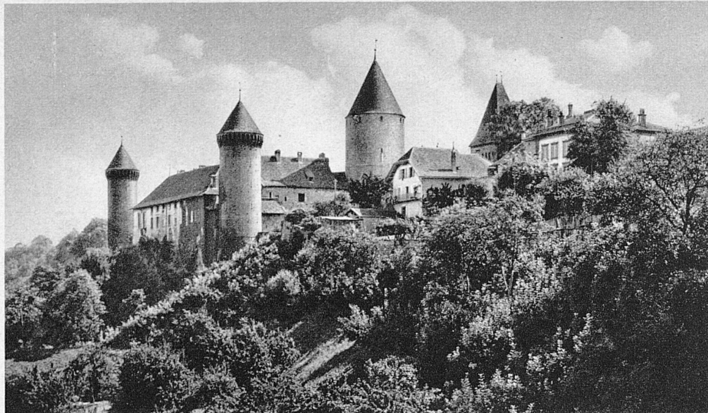
Le château d'Estavayer, dans le canton de Fribourg, au bord du lac de Neuchâtel - Schloss Estavayer im Kanton Freiburg, nah am Ufer des Neuenburgersees - Il Castello di Estavayer (Ct. Friburgo) presso le rive del Lago di Neuchâtel
