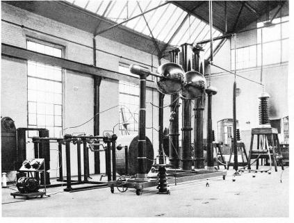
Stoßspannungsanlage für 1 Million Volt und 10000 Watt-sec. Leistung
