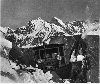
Cletrac-Schneeschleudermaschine an der Arbeit auf der Flumserbergstrasse -Le chasse-neige Cletrac en action sur la route de Flums
