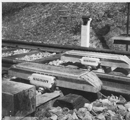
Links: Automatische Bremsung durch « Signum » — A gauche: Freinage automatique « Signum »
