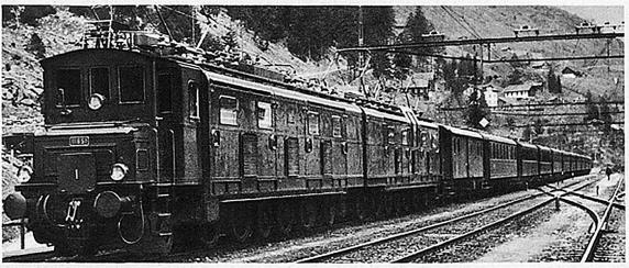
Die grössten, heute im Betrieb befindlichen elektrischen Lokomotiven sind 34 m lang und haben eine Zugkraft von 8500 PS – Les plus grandes locomotives électriques aujourd'hui en service ont une longueur de 34 m et 8500 CV de puissance
