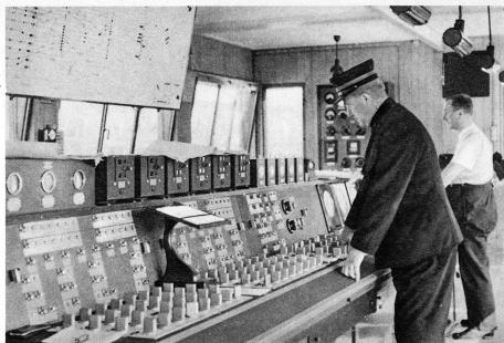
Das Innere des neuen Zürcher Befehlstellwerks: sanfte Schalterdrehung schleust die Züge durch das Schienengewirt der Einfahrt. Das Aufflackern von Kontrollämpchen auf der Orientierungstafel weist die Ausführung der Fernsteuerung nach – Au nouveau poste d'aiguillage de la gare de Zurich: un simple bouton à tourner et le train se dirige sürement à travers l'écheveau des rails. Une ampoule de contrôle qui s'allume au tableau d'orientation informe que la transmission s'est bien faite au signal
