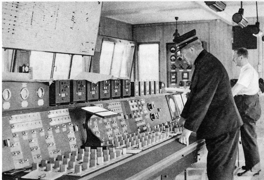
Das Innere des neuen Zürcher Befehlstellwerks: sanfte Schalterdrehung schleust die Züge durch das Schienengewirr der Einfahrt. Das Aufklappen von Kontrolllampchen auf der Orientierungstafel weist die Ausführung der Fernsteuerung nach — Au nouveau poste d'aiguillage de la gare de Zurich: un simple bouton à tourner et le train se dirige sûrement à travers l'écheveau des rails. Une ampoule de contrôle qui s'allume au tableau d'orientation informe que la transmission s'est bien faite au signal
