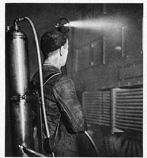
Der sogenannte Lokomotivkasten wird nicht mit Wasser abgespritzt. Er erhält eine Oeldusche, damit sein Glanz nicht verloren geht – La carrosserie est préalablement passée à l'huile
