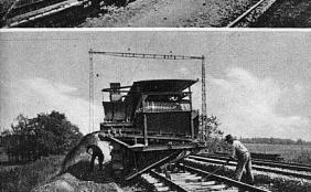
Machine à piocher, ameublir et désherber le ballast des voies de chemins de
