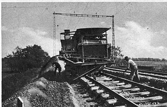
Machine à dégarnir et cibler le ballast des voies de chemins de fer
