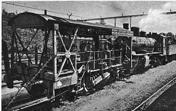
Machine à piocher, ameublier et désherber le ballast des voies de chemins de fer
