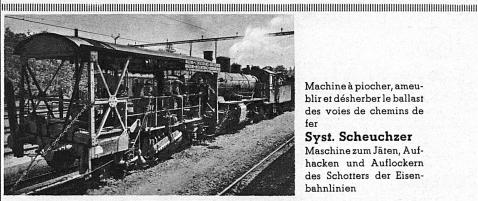
Machine à piocher, ameublir et désherber le ballast des voies de chemins de
