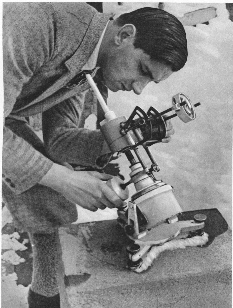
Dieser Apparat registriert automatisch die Sonnenscheindauer, indem die durch eine Linse gesammelten Sonnenstrahlen eine Brennsur auf eine Walze schreiben – Cet appareil enregistre automatiquement l'insolation du fait que les rayons solaires, concentrés dans une lentille, sont enregistrés par une trace carbonée sur un tambour
