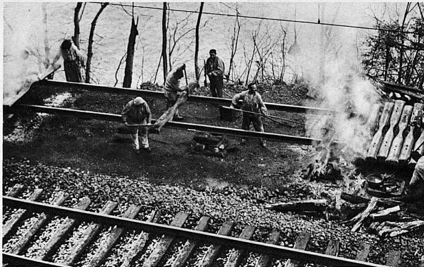
Am Wallensee, zwischen Ofenegg-Weisswand- und Standenhorn-tunnel sind im vergangenen Monat die eisernen Schutzwände gegen Steinschlaggefahr erneuert worden. Unser Bild zeigt die Arbeitsstelle, von der die Rauchsäule des Teerofens aufsteigt – Au bord du Wallensee, entre Ofenegg-Weisswand et le tunnel de Standenhorn, on a été obligé de remplacer, le mois dernier, les murs de défense contre les avalanches. On voit, sur notre photographie, les colonnes de fumée qui montent des fourneaux de goudron du chantier du travail
