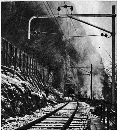
Am Wallensee, zwischen Ofenegg-Weisswand- und Standenhornstunnel sind im vergangenen Monat die eisernen Schutzwände gegen Steinschlaggefahr erneuert worden. Unser Bild zeigt die Arbeitsstelle, von der die Rauchsäule des Teerofens aufsteigt – Au bord du Wallensee, entre Ofenegg-Weisswand et le tunnel de Standenhorn, on a été obligé de remplacer, le mois dernier, les murs de défense contre les avalanches. On voit, sur notre photographie, les colonnes de fumée qui montent des fourneaux de goudron du chantier du travail
