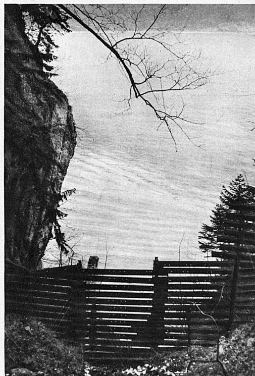
Ein Schutzgitter, 100 Meter über den Schienen. Man sieht am linken Fache die tiefe Beule, die ein Stein schlug, ehe er zum Stillstand gebracht wurde – Une palissade de défense, 100 m au-dessus des rails. A gauche, on voit un panneau qui a été enfoncé par une grosse pierre, avant d'avoir été arrêté dans sa course par la palissade de défense
