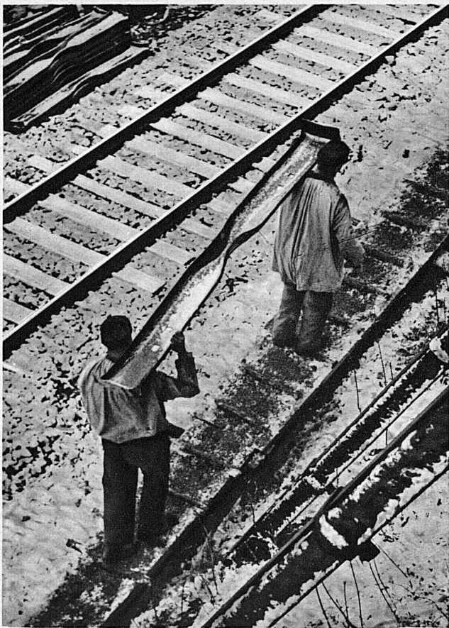
Eine eiserne Schwelle — Gewicht 50 Kilogramm — wird auf schmalen Laufsteg bergan getragen — Une traverse en fer (poids 50 kg) est transportée sur la montagne par un étroit sentier à échelons
