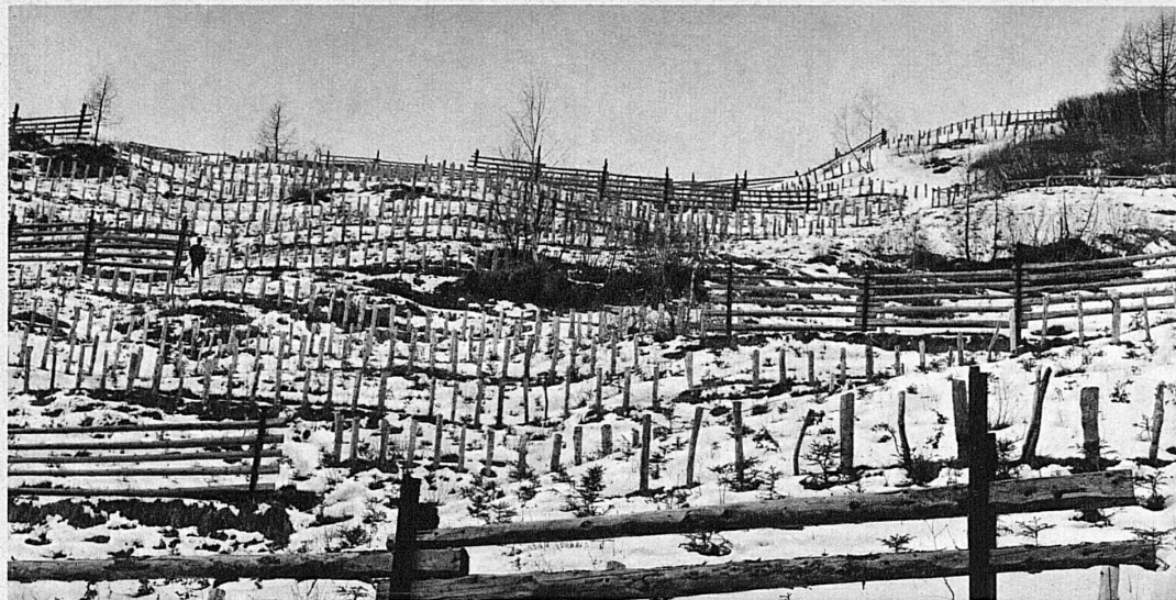
Wie ein Schlachtfeld sehen die Hangverbauungen der Schweizer Alpenbahnstrecken aus – Des « barbelés » en Suisse? Non pas, les travaux de protection des lignes alpestres
