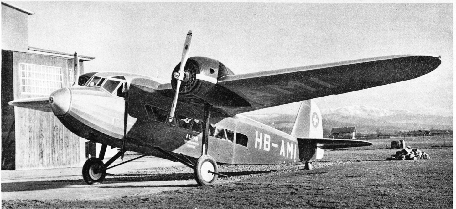
Das neue zweimotorige Verkehrsflugzeug Typ Koolhoven F. K. 50 der Alpar-Bern bietet dank der Anordnung der Tragflächen den Passagieren eine völlig freie Sicht nach unten – Nouveau modèle d'avion Typ Koolhoven F. K. 50, grâce à la position de ses ailes, les voyageurs jouissent du panorama au-dessus duquel ils survolent
