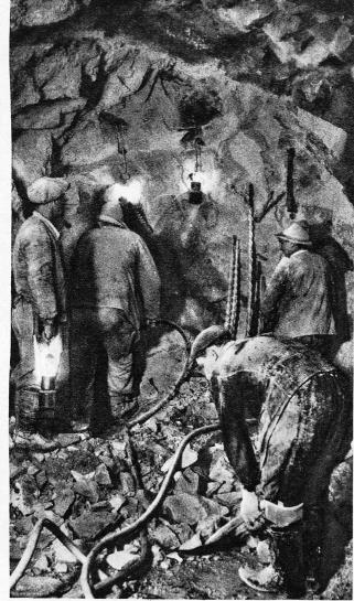
Sprengungsarbeiten im Druckstollen - Percement du tunnel d'amenée
