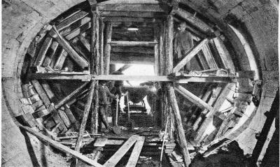
Beim Ubergang zur Druckleitung wird der Druckstollen, zur Aufnahme des Hosenrohrs, oval – Raccordement ovale du tunnel d'amenée
