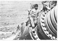
55000 m² misst die neue Dixence-Druckleitung in Sion, und auch diese wurde wieder mit Ineriol und Inertol-dick gegen Rost geschützt. Inertol ist reines Schweizer Fabrikat.
