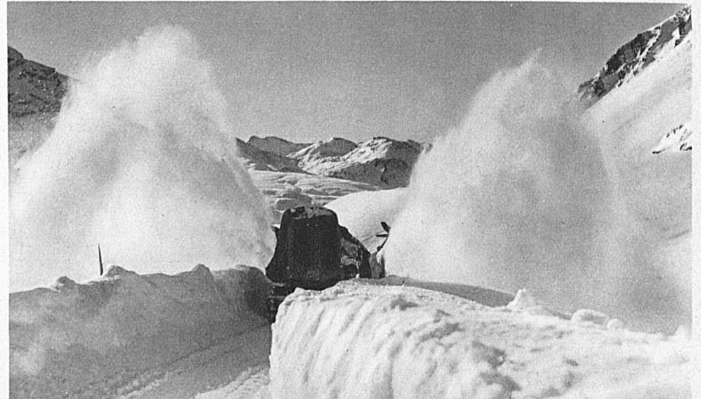
A powerful snow-plough at work on the Julier Pass, the great motor-road in the Engadine — Die mächtige Schneeschleuder öffnet den Julier, die grosse Auto-Paßstrasse ins Engadin — Le chasse-neige du Julier, la grande voie automobile de l'Engadine
