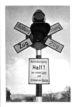
Neue Verkehrssignale für offene Bahnübergänge. Die Schweiz. Bundesbahnen führen neue Verkehrs-Blinksignale für offene Bahnübergänge ein. — Beim Herannahen des Eisenbahnzuges stoppen Signalglocke und rotes Blinklicht den Verkehr.
