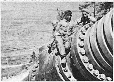
55000 m<sup>2</sup> misst die neue Dixence-Druckleitung in Sion, und auch diese wurde wieder mit
