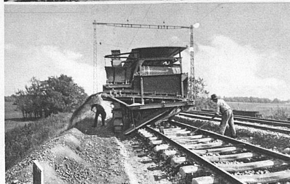
Machine à dégarnir et crible le ballast des voies de chemins de fer
