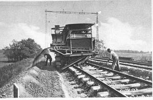
Machine à dégarnir et cribler le ballast des voies de chemins de fer **Syst. Scheuchzer** Maschine zum Ausheben und Sieben des Unter-
