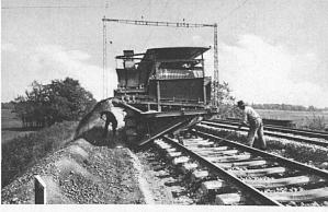
Machine à dégarnir et cribler le ballast des voies de chemins de fer **Syst. Scheuchzer** Maschine zum Ausheben und Sieben des Unterbaues d. Eisenbahnlinien
