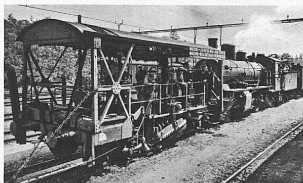
Machine à piocher, ameublier et désherber le ballast des voies de chemins de fer
