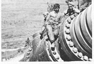
55000 m² misst die neue Dixence-Druckleitung in Sion, und auch diese wurde wieder mit Inertol und Inertol-dick gegen Rost geschützt. Inertol ist reines Schweizer Fabrikat.
