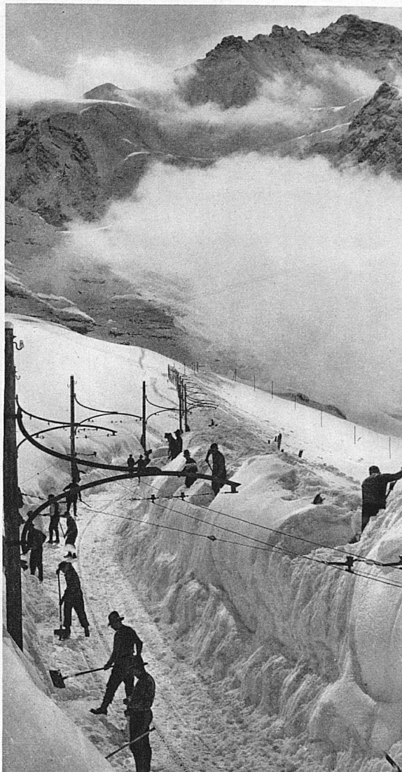
Chaque jour le vent de la nuit comblant la tranchée de la veille, chaque jour les déblayeurs doivent refaire le lit du convoi
