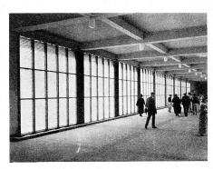
Gradierwand in der neuen Kurbrunnenanlage in Rheinfelden. Durch Abtropfen von Sole über die 4 Meter hohe Glaswand mit 7000 Glassprossen entsteht eine stärkende, salzhaltige Luft, die zu Heilzwecken eingeatmet wird.
