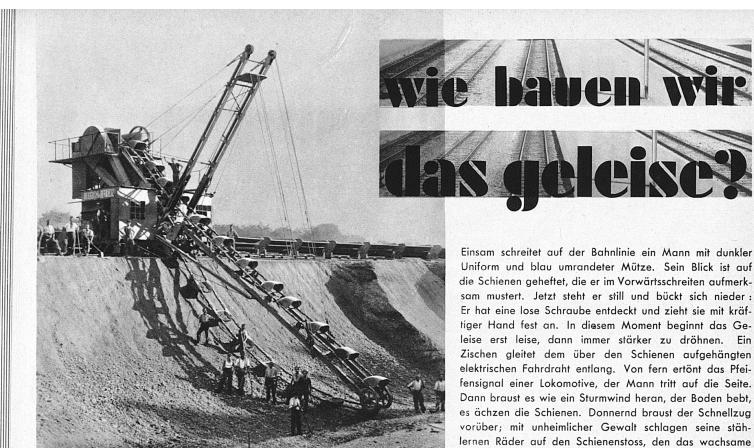
Ausheben eines Einschnittes durch einen Löffelbagger. Das ausgehobene Material wird durch Rollwagen abgeführt
