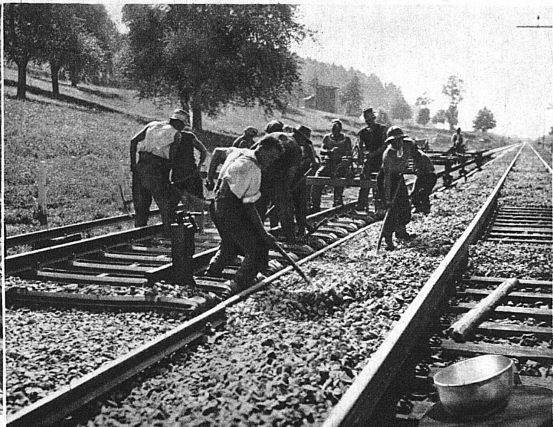
Das auf Eischwellen fertigverschraubte Geleisestück wird auf Tragrollen vorgeschoben
