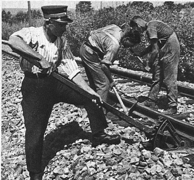
Das gelegte Geleise wird eingeschottert. Tragwinden heben die Stoßschwellen auf die richtige Höhe
