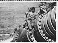
55000 m<sup>2</sup> misst die neue Dixence-Druckleitung in Sion, und auch diese wurde wieder mit Inertol und Inertol-dick gegen Rost geschützt. Inertol ist reines Schweizer Fabrikat.
