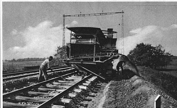
Machine à dégarnir et cribler le ballast des voies de chemins de fer
