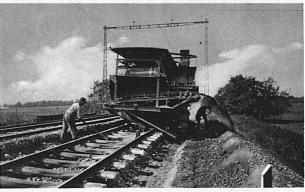
Machine à dégarnir et cribler le ballast des voies de chemins de fer **Syst. Scheuchzer** Maschine zum Ausheben und Sieben des Unter-
