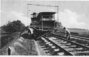
Machine à piocher, ameublir et désherber le ballast des voies de chemins de
