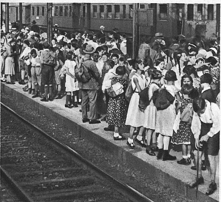
Schulreisebetrieb auf dem Perron
