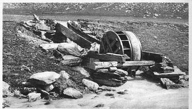
Butterbereitung auf der Alp. Antrieb des Butterfasses mit dem Wasserrad
