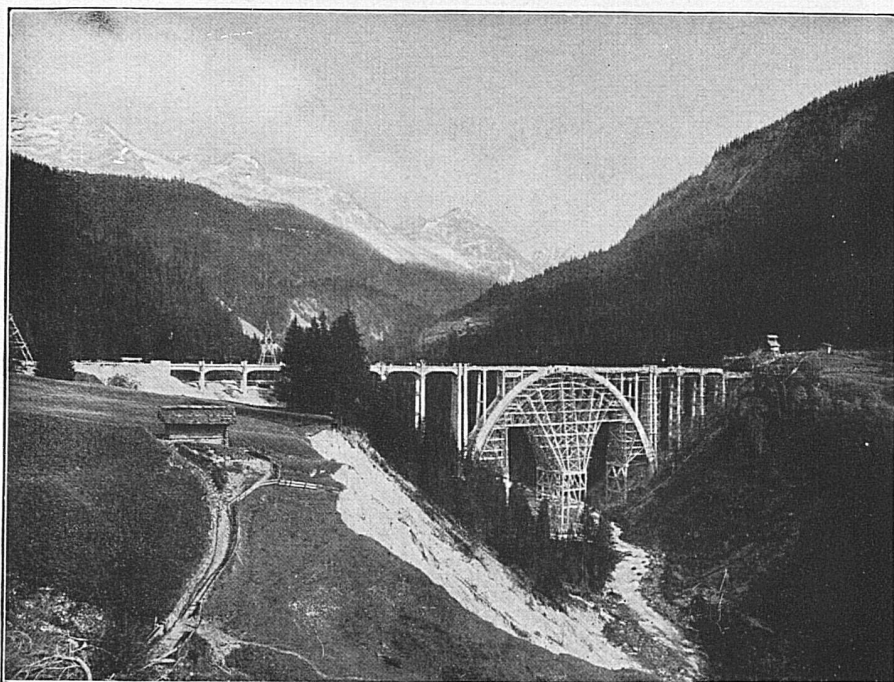
Viadukt bei Langwies während der Bauausführung
