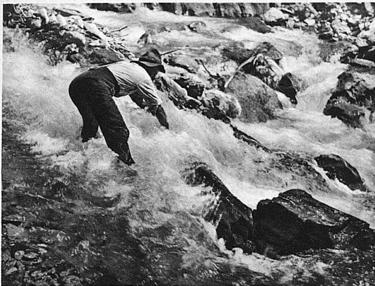
Die Wasserleitung im Gredetschtal ist bei der „Aschöpfi“ ausgebrochen. Balken und Steine werden herbeigeschleppt, um die Bresche zu schliessen, aber das wilde Wasser droht alles wieder wegzureissen.
