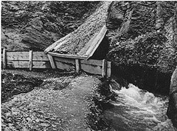
Links: Kurz nach der Fassung gelangt das Wasser in die "Arche", das ist eine Art Klärbecken, in welchem Sand und Steine zurückbleiben. Durch verschliessbare Offnungen wird das Oberflächenwasser ausgelassen. Die Arche muss täglich gereinigt werden.
