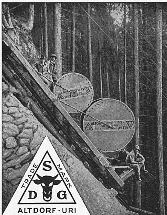
Verlegung der Bleikabel für KW-Sernf-Niedererbach.
