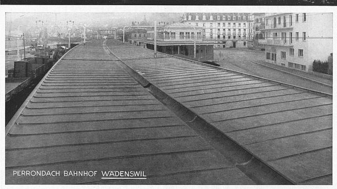
TECUTA-Kupferbronzeband, für Bedachungszwecke, in den Stärken von 0,3 u. 0,4 mm, in Bändern bis zu 35 m Länge, der ideale, unverwüstliche Flachund Steildachbelag, ohne Querfalz, geräuschlos bei Wind und Regen.
