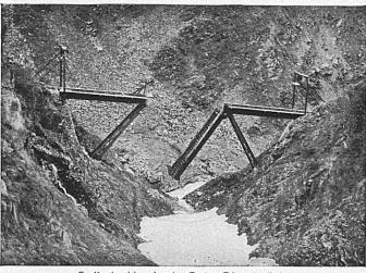
Steffenbachbrücke der Furka-Oberalp-Bahn Diese Brücke wird jeden Winter wegen Lawinengefahr zusammengeklappt, auf die Wider-lager zurückgelegt und im Frühjahr wieder hochgezogen und zusammenmontiert
