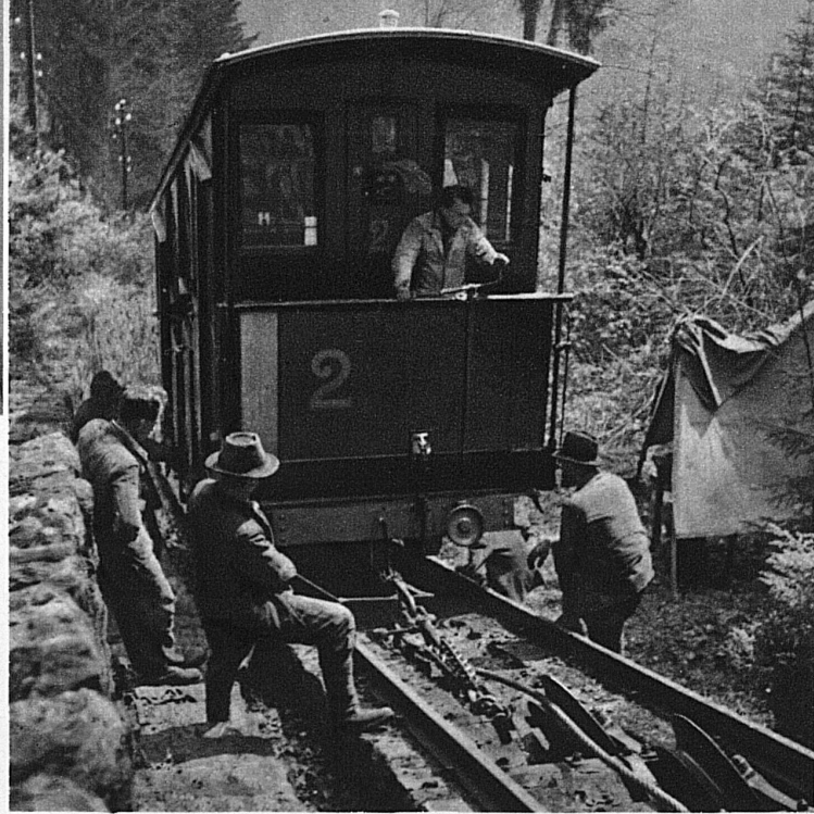
Bei den Bremsproben. Ein Wagen, voll belastet, wird vom Seil gelöst und hängt nur an einer Kette. Das Kontrollpersonal wartet auf den Moment, wo er, jeder Führung bar, lossaust und automatisch auf einer bestimmten Strecke, dem «Bremsweg», anhalten muss. Die Länge dieses Bremsweges ist vom Eisenbahndepartement genau festgelegt. Unten: Ein Ingenieur beim Messen des Bremsweges
