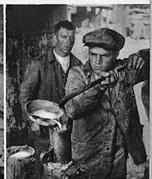
Jeder Draht muss frei gemacht und zurückgebogen werden, um im Seilkopf haltzumachen. Dann wird der Seilkopf noch mit Metall ausgegossen
