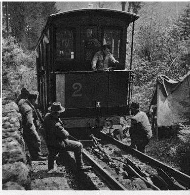
Bei den Bremsproben. Ein Wagen, voll belastet, wird vom Seil gelöst und hängt nur an einer Kette. Das Kontrollpersonal wartet auf den Moment, wo er, jeder Führung bar, lossaust und automatisch auf einer bestimmten Strecke, dem «Bremsweg», anhalten muss. Die Länge dieses Bremsweges ist vom Eisenbahndepartement genau festgelegt. Unten: Ein Ingenieur beim Messen des Bremsweges
