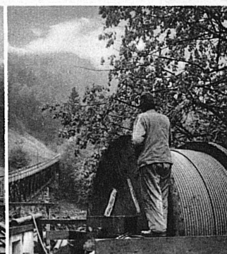
Das 2230 Meter lange und 8920 kg schwere Seil wird am Wagen befestigt und zur Höhe gezogen. Es rollt von einem grossen Haspel ab
