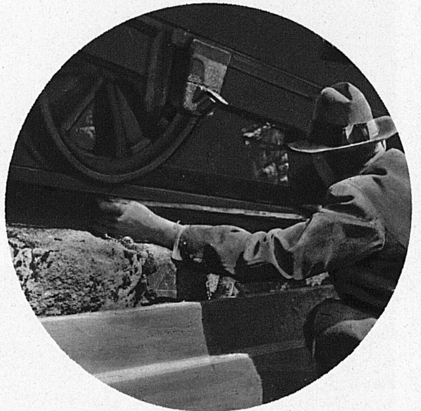
Jeder Draht muss frei gemacht und zurückgebogen werden, um im Seilkopf haltzumachen. Dann wird der Seilkopf noch mit Metall ausgegossen
