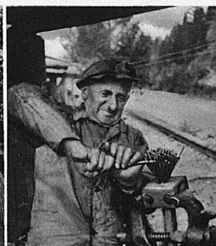
Jeder Draht muss frei gemacht und zurückgebogen werden, um im Seilkopf haltzumachen. Dann wird der Seilkopf noch mit Metall ausgegossen
