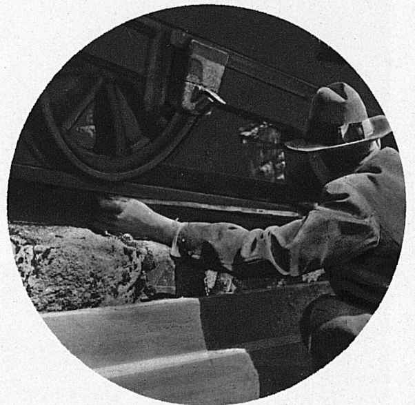
Jeder Draht muss frei gemacht und zurückgebogen werden, um im Seilkopf haltzumachen. Dann wird der Seilkopf noch mit Metall ausgegossen
