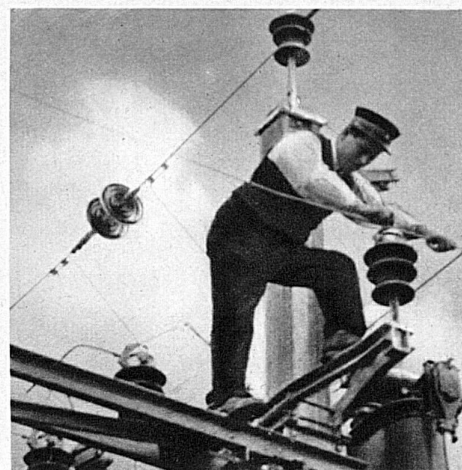
Die Montage der Fahrleitungen erfordert grosse Sorgfalt
