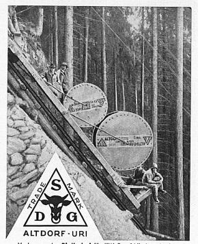
Verlegung der Bleikabel für KW-Sernf-Niederenbach. Pose des câbles sous plomb pour la Centrale de Sernf-Niederenbach
