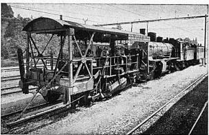
Machine à dégarnir et cribler le ballast des voies de chemins Machine à piocher, ameublir et désherber le ballast des voies de fer
