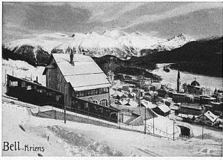
Drahtseilbahn St. Mority-Chantarella, Engadin, erstellt 1913, umgebaut 1931 auf höhere Leistungsfähigkeit, mit Wagen für 70-50 Personen bei 3 m/sec. Fahrgeschwindigkeit und Triebwerk mit elektrischer Fernsteuerung von den Wagen aus
