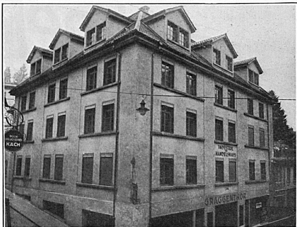
Geschäfts- und Lagerhaus zum „Graggenthor“ Luzern. Stahlskelettbau mit 4 innern Säulensträngen, sonst völlig freitragenden, für grosse Lasten berechneten Decken, welche eine Aufteilung des Innenraumes nach Belieben gestatten
