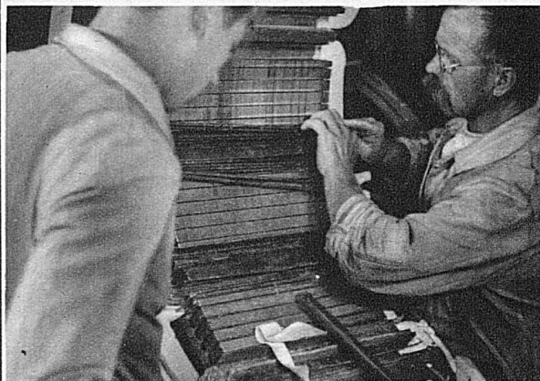
Einlegen der Statorwicklungen
