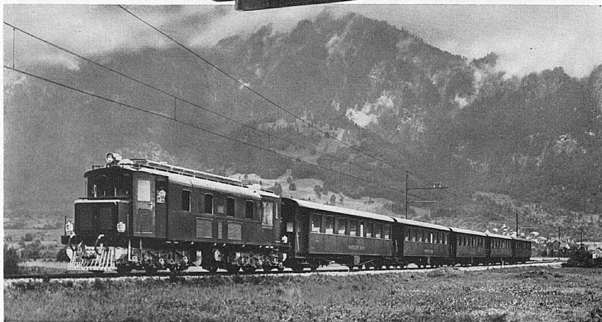
Die erste von sechs für die Siamesischen Staatsbahnen gelieferten 450 PSe Sulzer-Diesel-Lokomotiven Versuchsfahrt auf dem Netz der Rhätischen Bahnen
