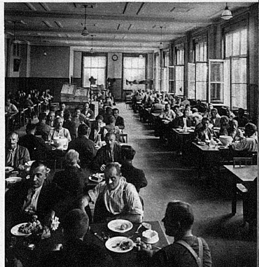
Früher: Kleiner Innenraum, unbequeme Bänke, kleine Holzrahmenfenster, 1870 noch eingebaute eiserne, rauchende Kohlenöfen und russende Petroleumlampen. 1890 die Dampfheizung und feuergefährliche Gasbeleuchtung; mangelhafte Ventilation.
