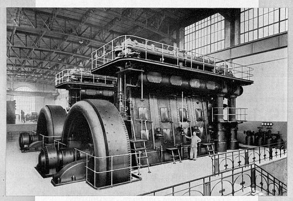
Die Abbildung zeigt die mit zwei Sulzer-Dieselmotoren von je 3000 PS e ausgerüstete Zentrale Coulouvrenière der Stadt Genf
