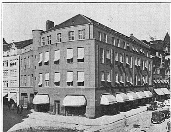
Eidg. Telephonegebäude Füsslistrasse, Zürich Stahlskelettbau, in den Hauptstockwerken völlig frei von inneren Eisenstützen
