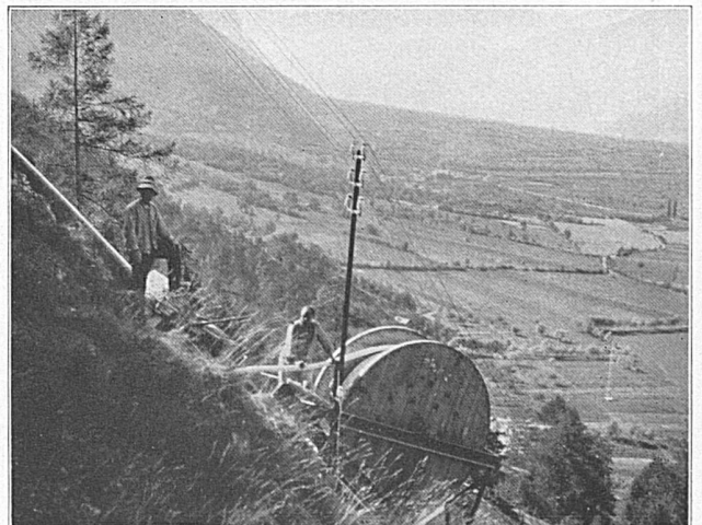
Pose en montagne de câbles à haute tension
