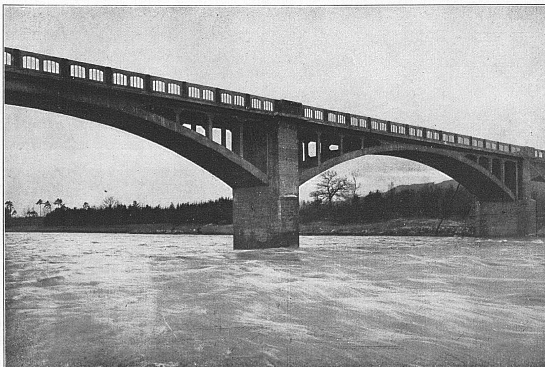
Strassenbrücke über die Thur bei Weinfelden
